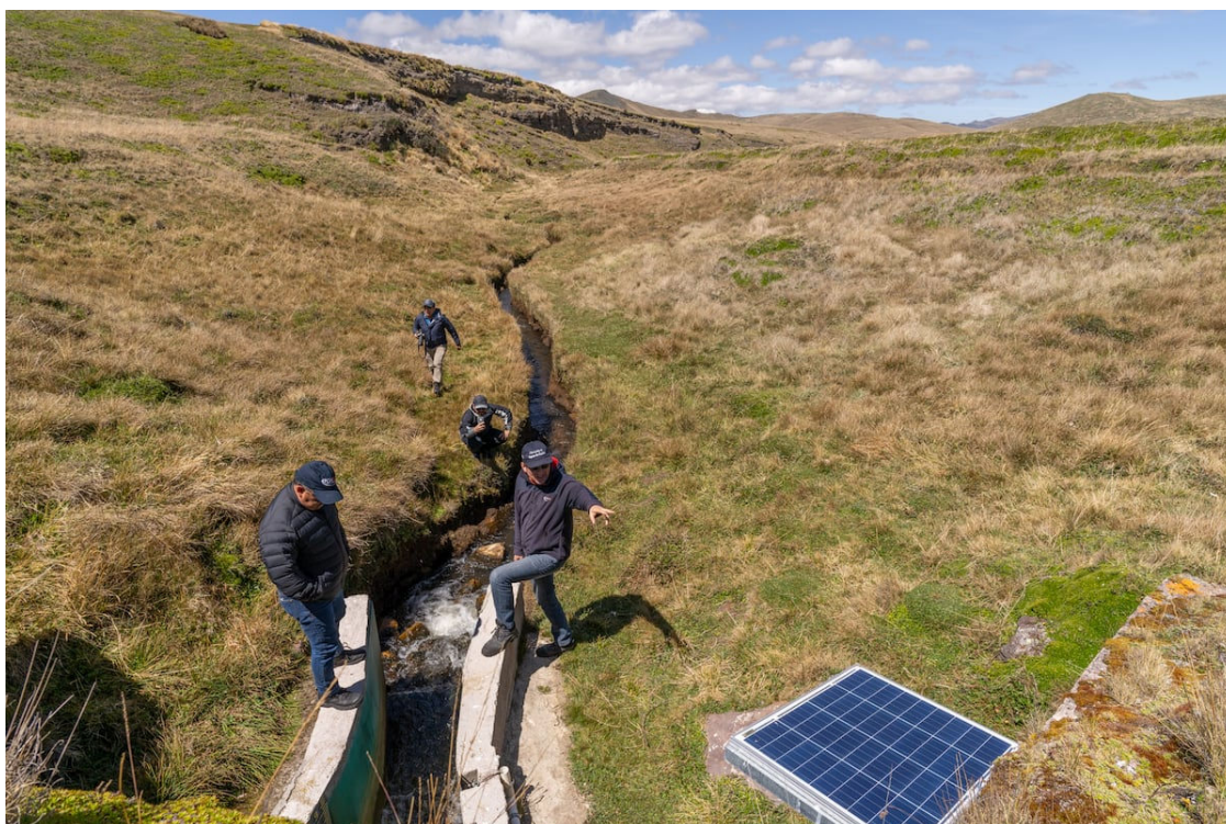
Personas realizan trabajos de infraestructura hídrica cerca del volcán nevado Antisana, en Ecuador. Sebastián Di Domenico (TNC)
