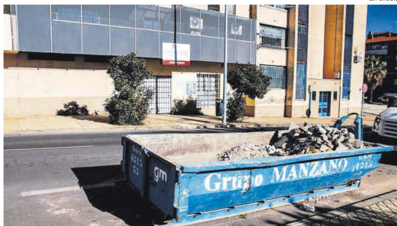
Obras en la calle río Tiber.
